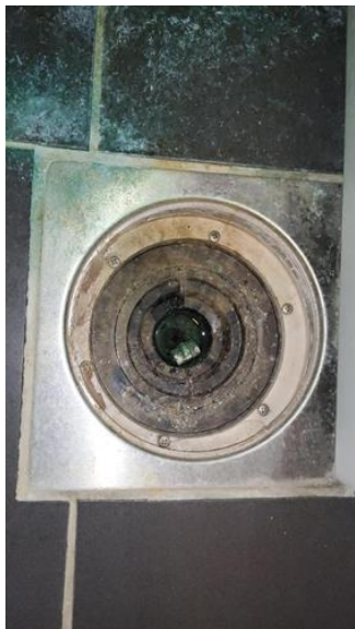
Overflater gulv - [Sluk bod/teknisk rom]
