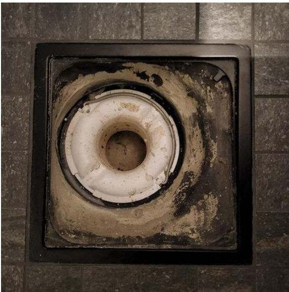
Avløpsrør (ink. sluk) - [Sluk bad ved entre]
