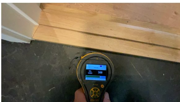
Fuktsøk på gulv ved dørterskel uten forhøyde fuktavvik
