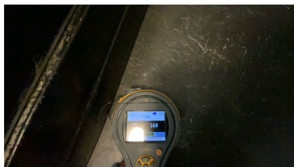
Fuktsøk på gulv ved dusjkabinett uten forhøyde fuktavvik
