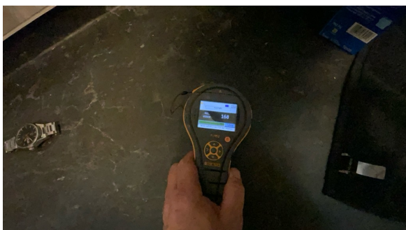
Fuktsøk på gulv under servantskap uten forhøyde fuktavvik
