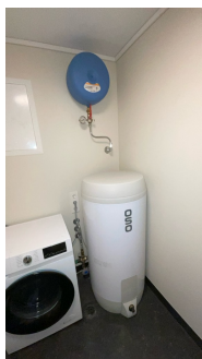
Varmtvannsbereider og ekspansjonstank
