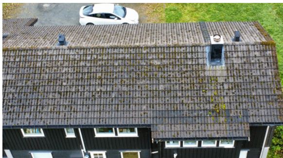
Oversikt pipe, luftehatt og takstige
