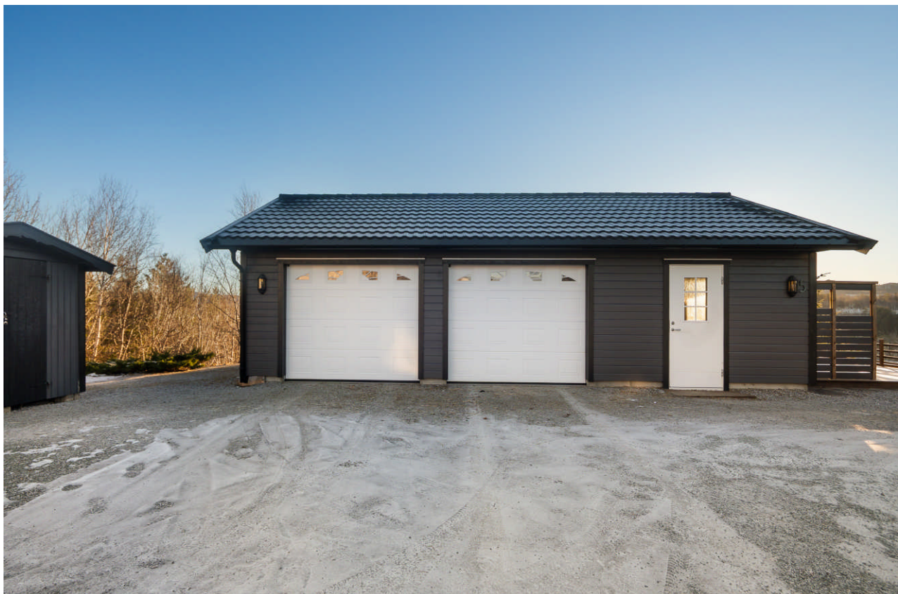
Stor dobbelgarasje med inngang til eget treningsrom. SAMt en utebod helt til venstre i bildet.
