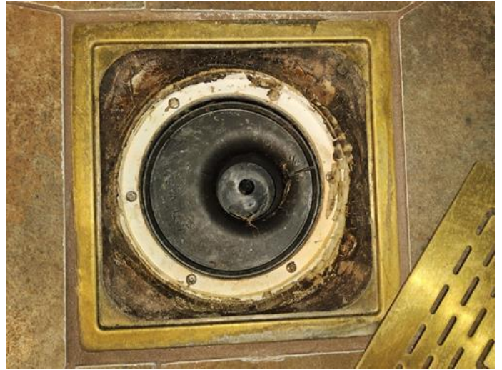
Våtrom - [Sluk bad dusjsone. ]
