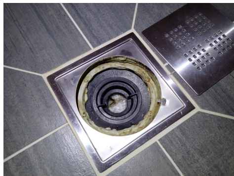
Sluk på bad/vaskerom
