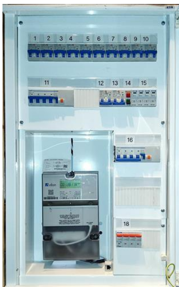
Forenklet vurdering av det elektriske anlegget - [Sikringsskap]
