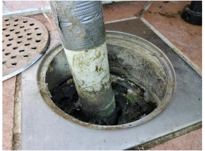
Membran, tettesjikt og overgang til sluk. - [Sluk]
