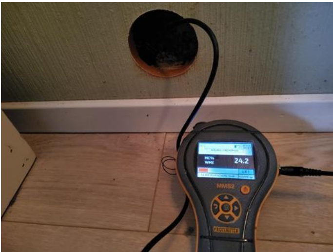
Konstruksjoner (tilfarergulv, himling og vegger). - [Fuktmåling]
