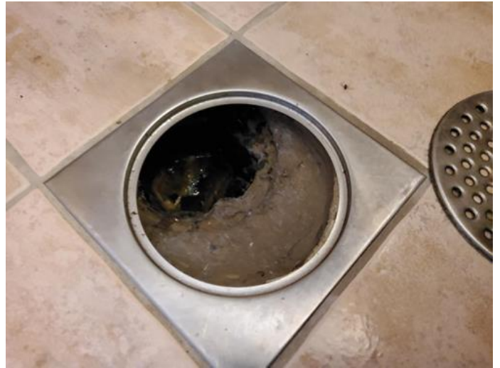
Membran, tettesjikt og overgang til sluk. - [Sluk]
