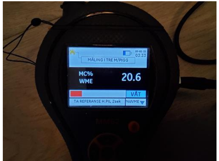
Konstruksjoner (tilfarergulv, himling og vegger). - [Fuktmåling 1.etasje]
