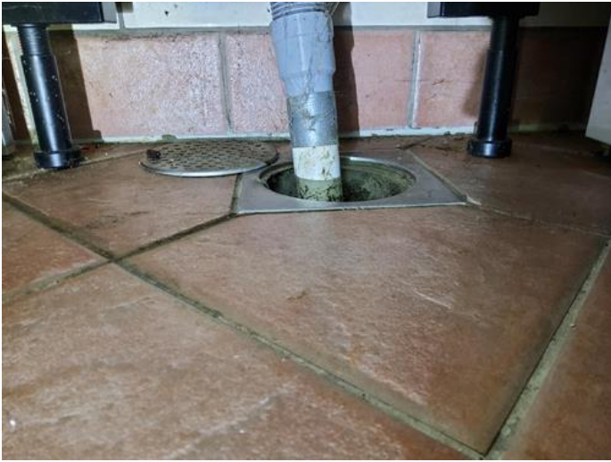
Membran, tettesjikt og overgang til sluk. - [Sluk]
