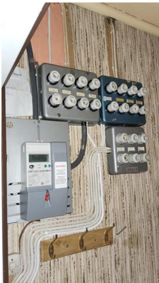
Forenklet vurdering av det elektriske anlegget - [Sikringer i trapperom]
