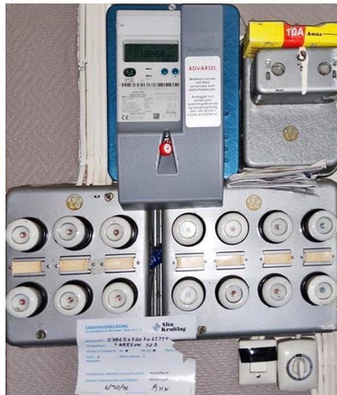
Forenklet vurdering av det elektriske anlegget - [Sikringer i gang]
