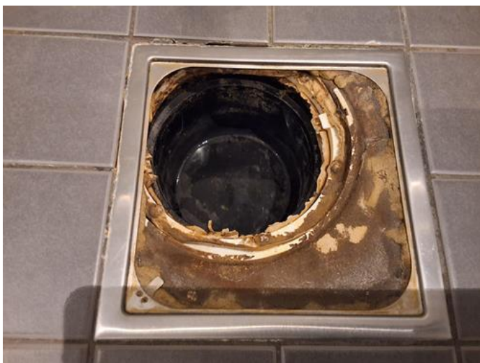
Våtrom - [Sluk på bad]
