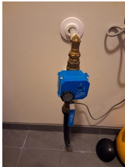
Tekniske anlegg, VVS anlegg (Sjekkpunkter utover det som er inkludert i andre rom) - [Stoppekran på vaskerom/bod]
