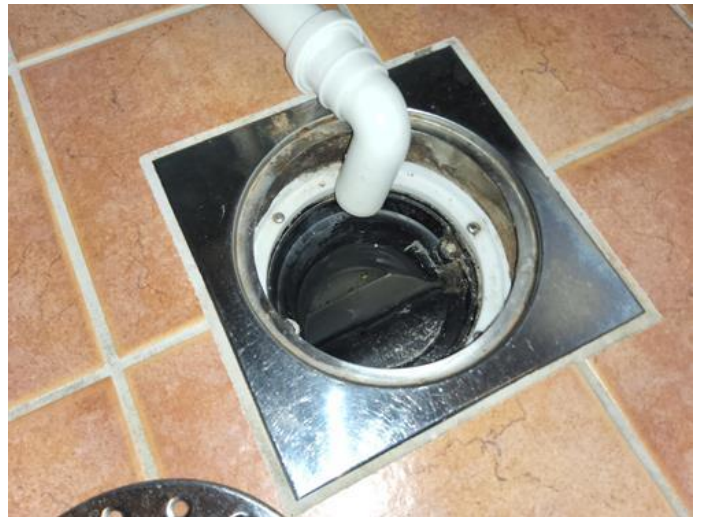
Våtrom - [Sluk på vaskerommet ]
