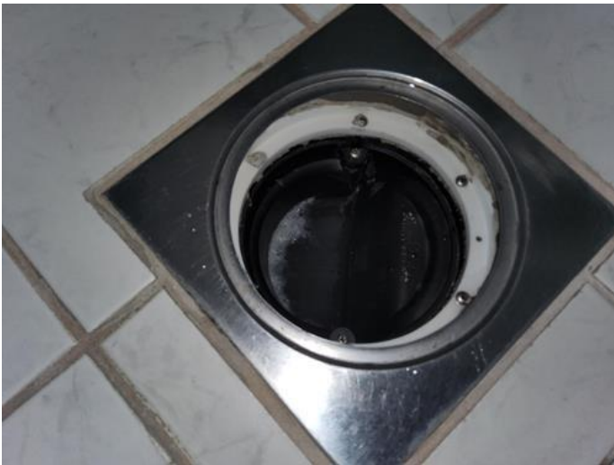
Våtrom - [Sluk på baderommet ]
