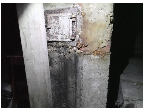
Sotluke i krypkjeller
