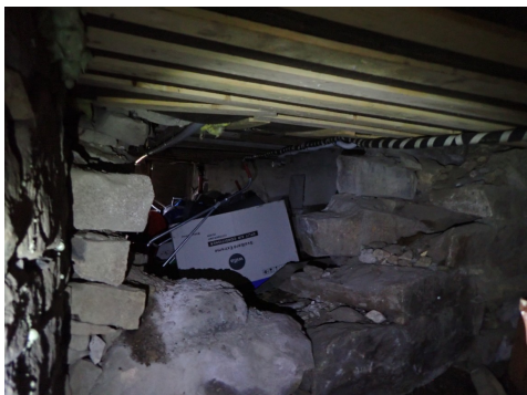
Krypkjeller, fra eldste del mot nyere del
