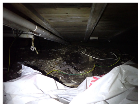
Kryprom mot nord, begrenset tilgang
