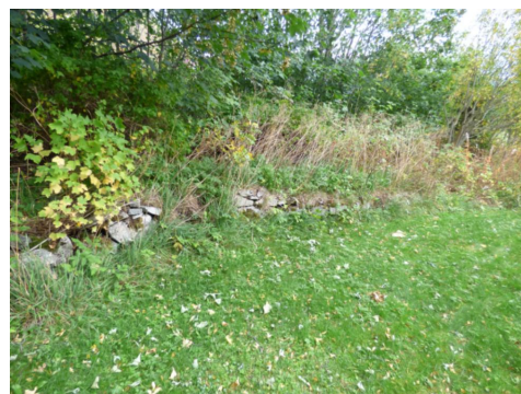
Forstøtningsmur i naturstein mot nord
