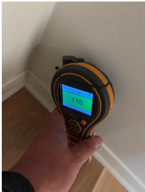
Fuktmåling mot våtsone uten avvik målt fra tilliggende bod.
