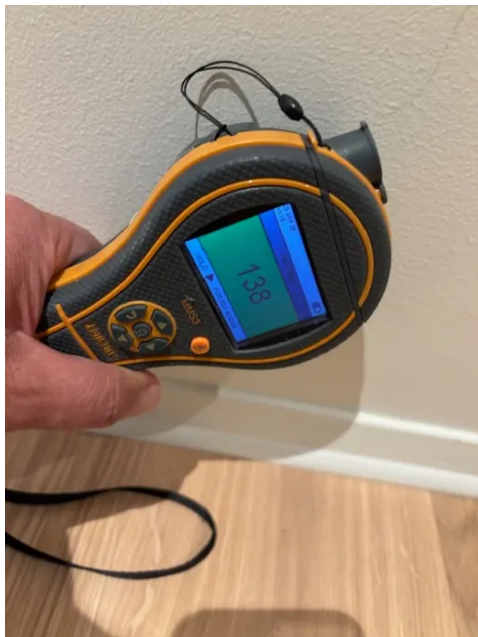
Fuktmåling mot våtsone uten avvik målt fra tilliggende gang/entre.
