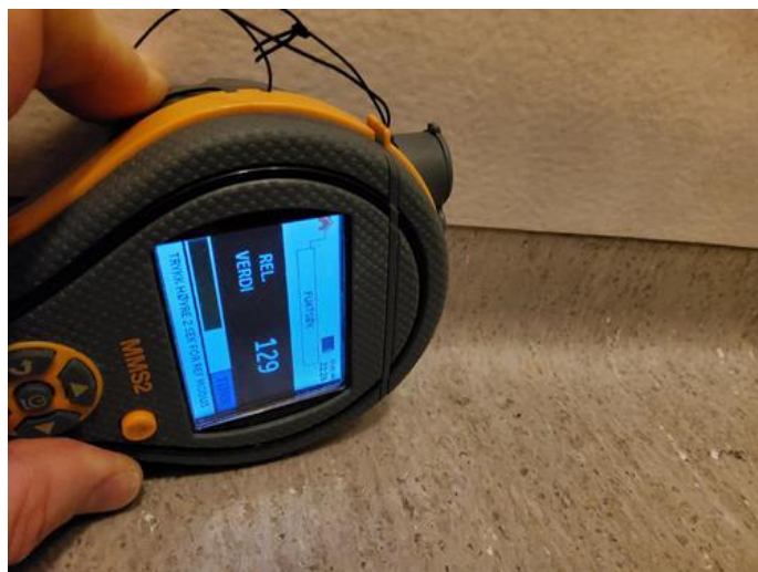
Kommentar - [Fuktsøk bad leilighet 1.]
