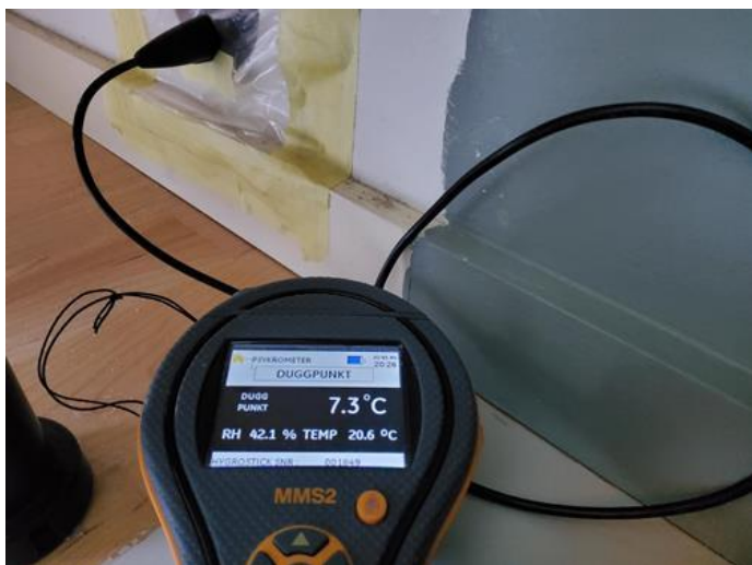
Kommentar - [Fuktmåling bad 2.etg. ]
