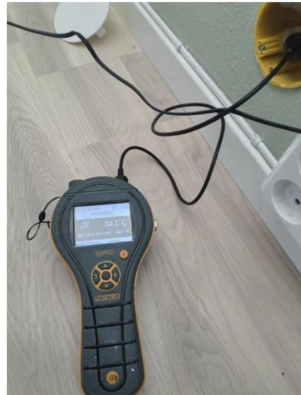
Fukt i tilliggende konstruksjoner - [Fuktmåling bad 2 etg]
