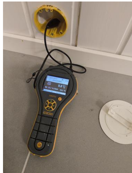
Konstruksjoner (tilfarergulv, himling og vegger). - [Fuktmåling kjellevegg ]
