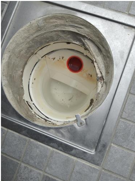
Slukets tilkomstmulighet for rengjøring - [Sluket på bad 2 etg]
