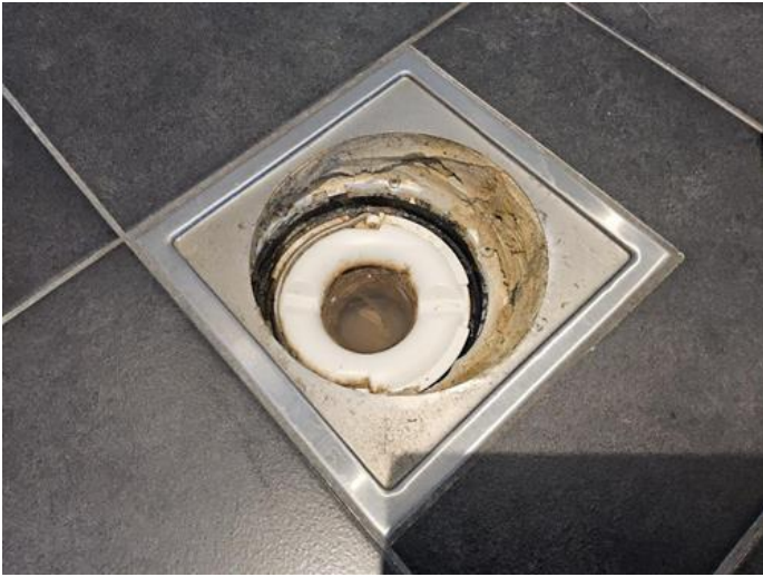
Våtrom - [Sluk på bad 3.etg. ]
