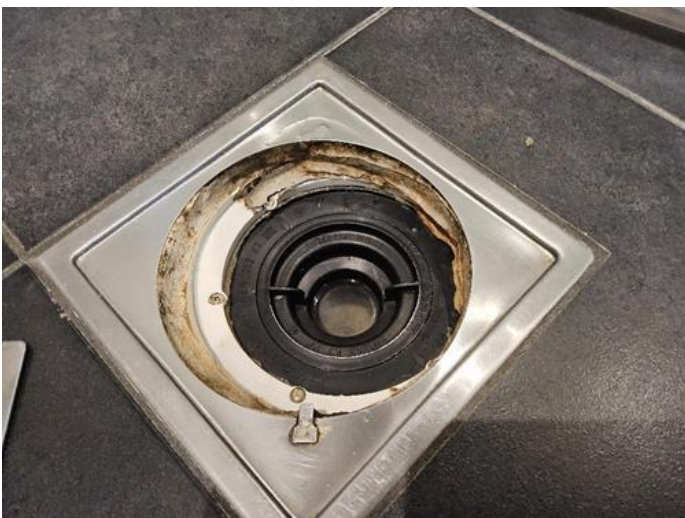
Våtrom - [Sluk på bad 1.etg. ]
