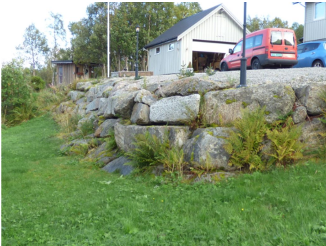
Støttemur mot nord, ved gårdsplass
