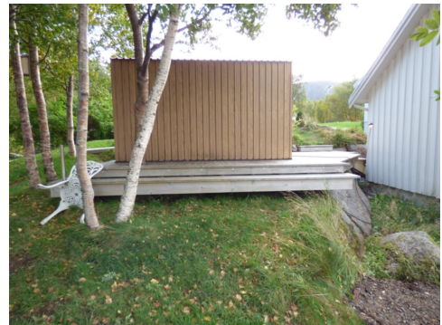
Platting bak garasjen
