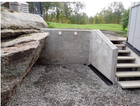
Støttemur i betong
