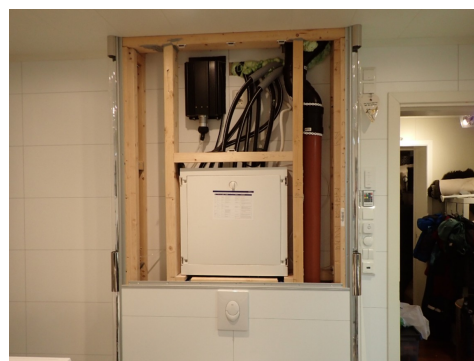
Øvre del av kasse rundt cisterne demontert
