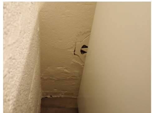
Sotluke, delvis skjult av fryser
