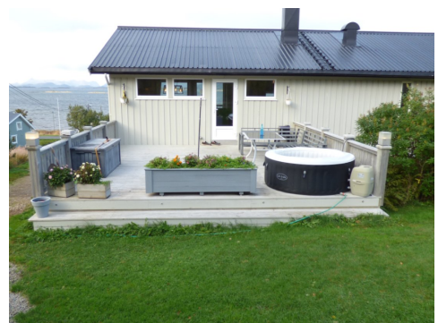
Veranda mot sør
