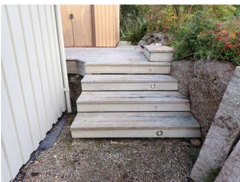
Trapp til platting ved garasjen
