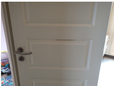
Skade i dør til bad
