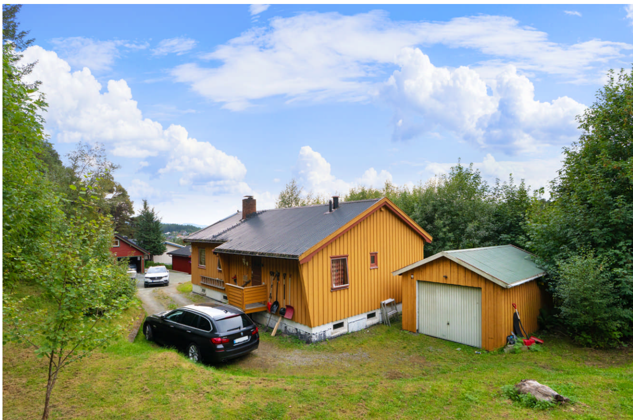
Frittstående garasje og flere oppstillingsplasser.
