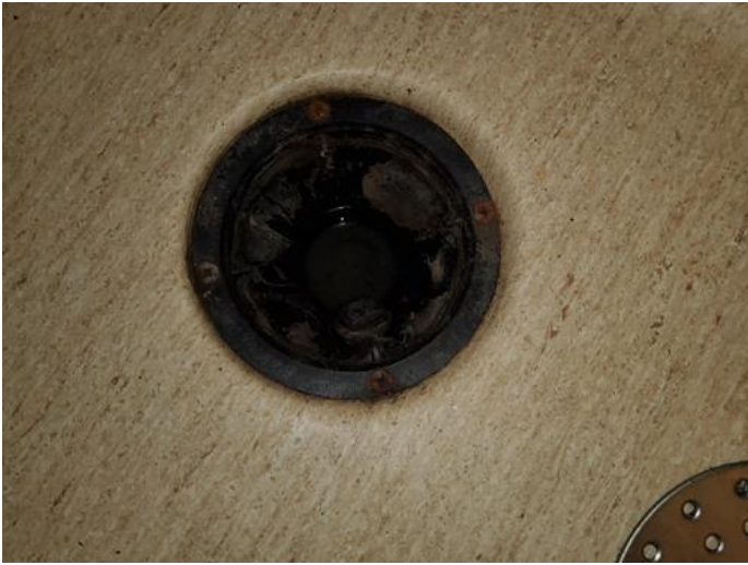
Våtrom - [Sluk bad 2.etasje]
