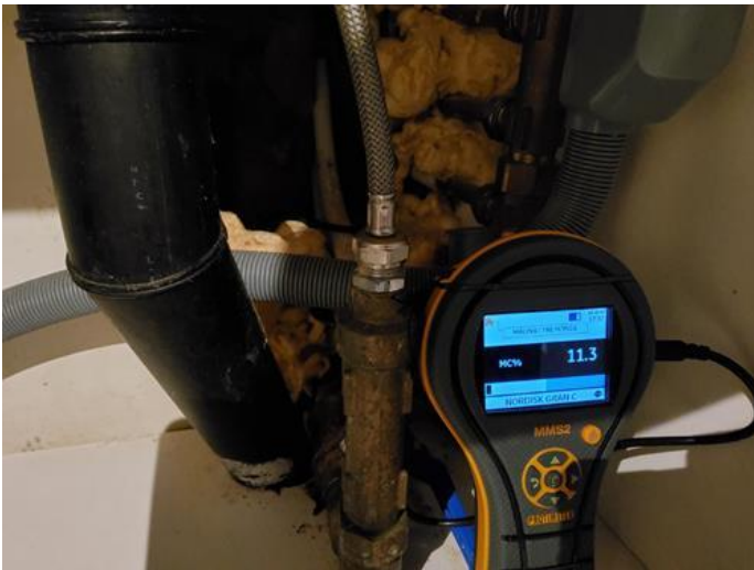
Kommentar - [Fuktmåling bad.]
