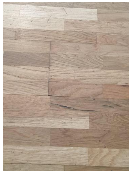
Overflater gulv - [Gulvflater i gang ]
