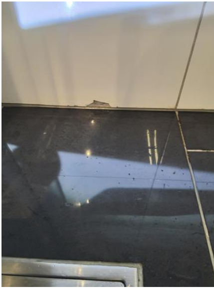
Overflater vegger - [Veggflis i dusjsonen ]
