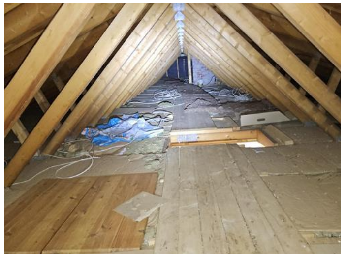
Loft - uinnredet / råloft - [Kaldtloft]
