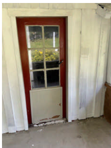
Balkongdør i 2.etasje.
