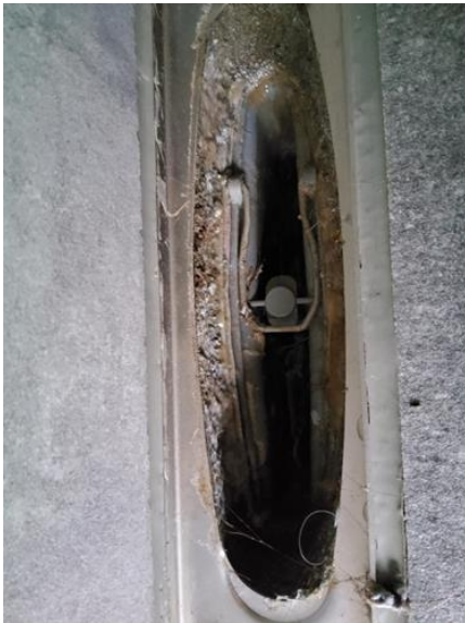
Membran, tettesjikt og overgang til sluk. - [Sluk i bad. 1. etg.]
