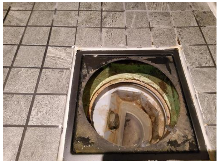
Membran, tettesjikt og overgang til sluk. - [Sluk i bad kjeller.]
