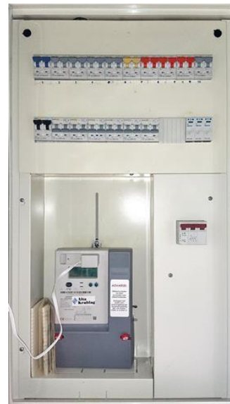
Forenklet vurdering av det elektriske anlegget - [Sikringsskap]
