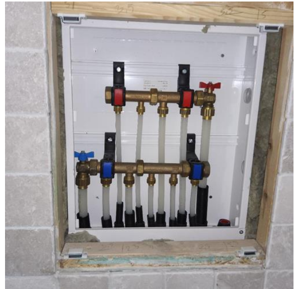
Tekniske anlegg, VVS anlegg (Sjekkpunkter utover det som er inkludert i andre rom) - [Fordelerskap for rør-i-rør system plassert på bad 2 i 2.etasje ]
