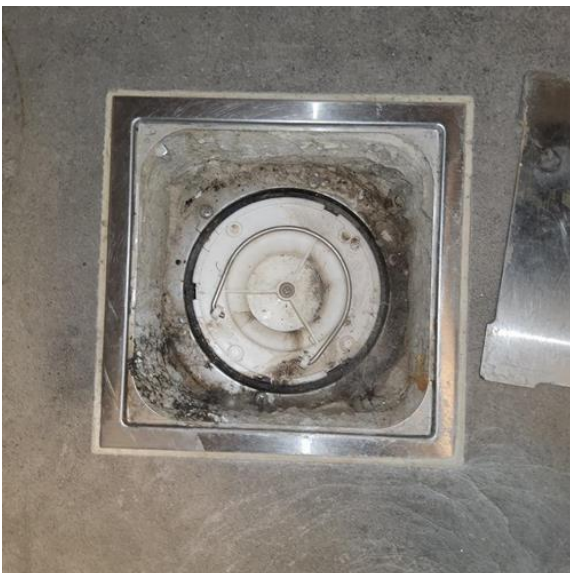
Tekniske anlegg, VVS anlegg (Sjekkpunkter utover det som er inkludert i andre rom) - [Sluk teknisk rom ]
