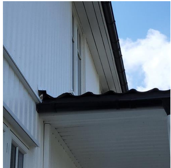
Utvendig - [Ufagmessig utførelse av blikk takoverbygg veranda]
