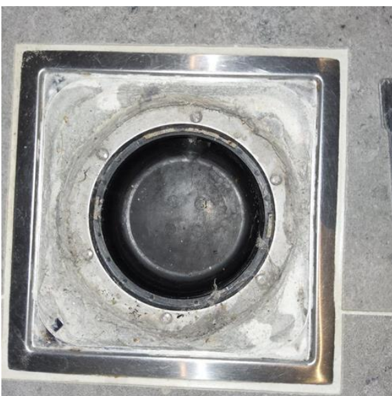
Avløpsrør (ink. sluk) - [Luk vaskerom ]
