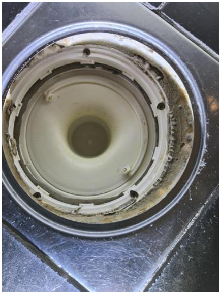
Slukets tilkomstmulighet for rengjøring - [Sluket i dusjsonen ]
