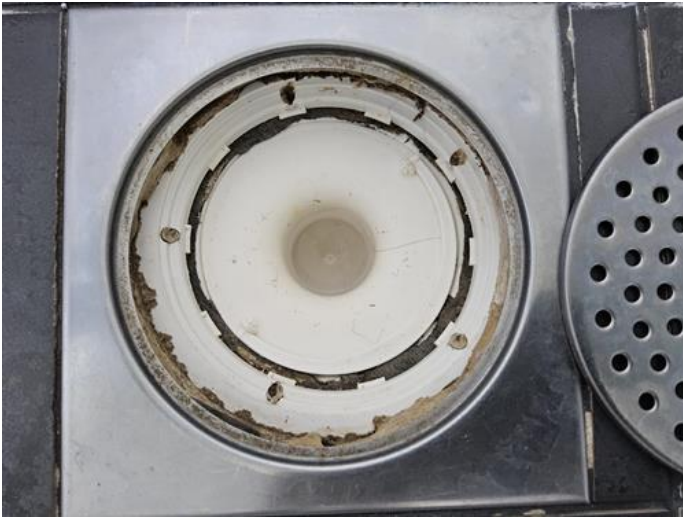
Våtrom - [Sluk bad dusjsone. ]
