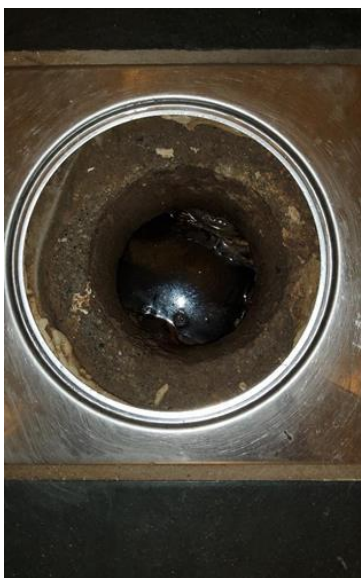
Membran, tettesjikt og overgang til sluk. - [Hovedsluk bad 2]
