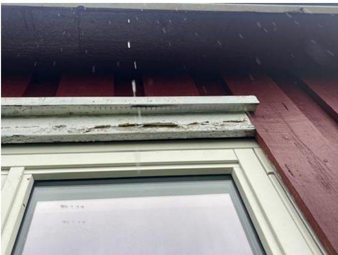
Annet - [Eksempel på åpninger rundt vindu]
