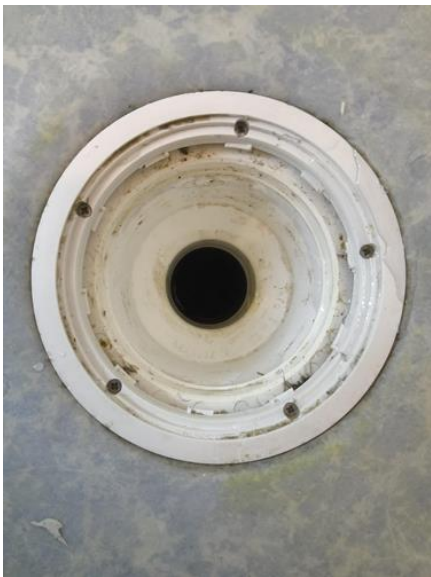
Slukets tilkomstmulighet for rengjøring - [Sluket under dusjkabinett på bad i kjeller ]
