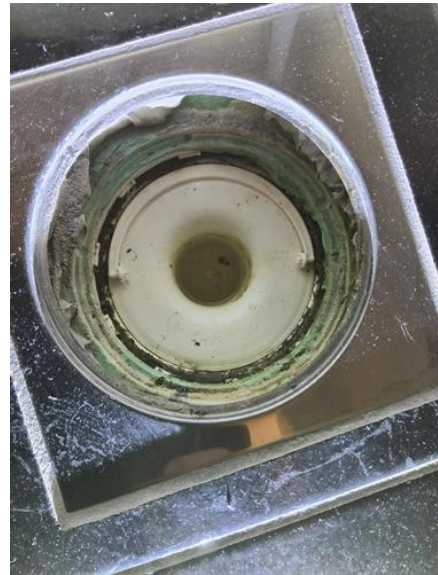
Slukets tilkomstmulighet for rengjøring - [Sluket på vaskerom ]
