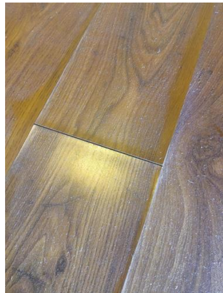
Overflater gulv - [Gulvflater ved kjøkken i kjeller ]
