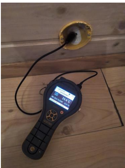
Konstruksjoner (tilfarergulv, himling og vegger). - [Fuktmåling kjellevegg ]
