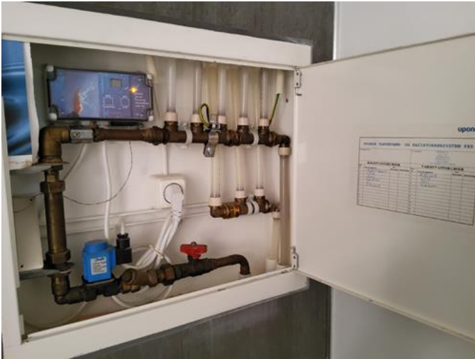
Kommentar - [Fordelerskap i bad.]
