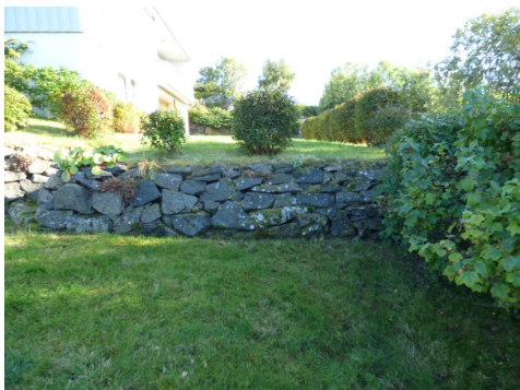
Forstøtningsmur rundt plen
