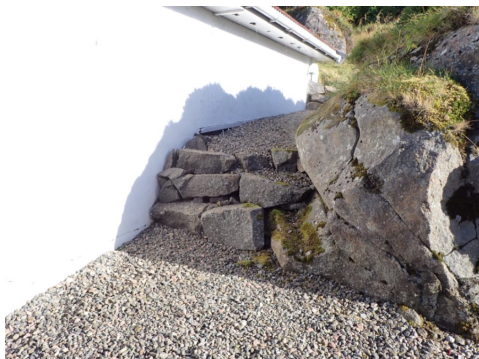
Trapp i naturstein ved garasjen
