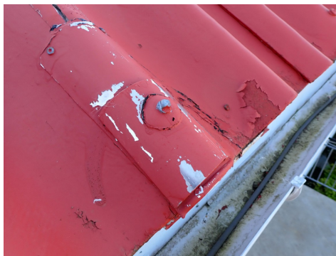
Midlertidige utbedringer ved takfot mot nordøst
