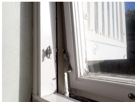
Vindu i teknisk rom kan bare åpnes litt
