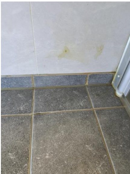
Overflater vegger - [Veggoverflater i dusjsonen. Bad kjeller ]
