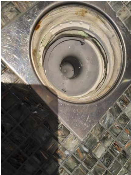
Slukets tilkomstmulighet for rengjøring - [Sluket i dusjsonen. Bad 2 etg ]
