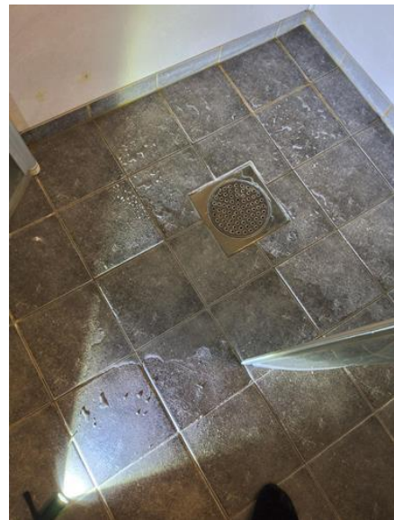
Fallforhold (gulv) - [Fallforholdet i dusjsonen. Bad kjeller ]
