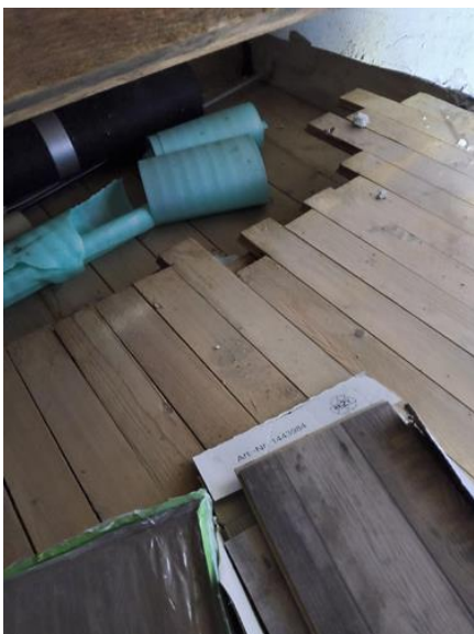
Konstruksjonsoppbygging - [Spør etter treskadeinsekter på kaldtloft ]
