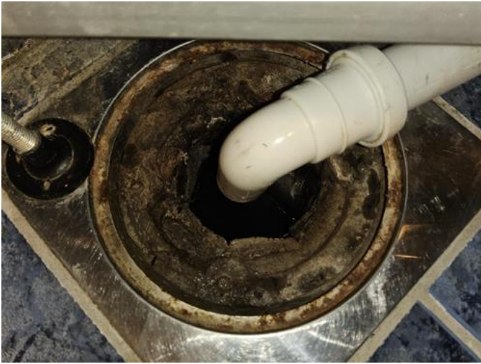
Våtrom - [Sluk bad.]
