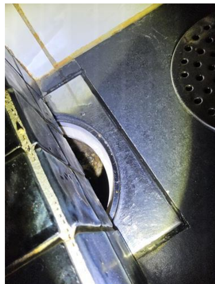
Våtrom - [Sluk på bad.]
