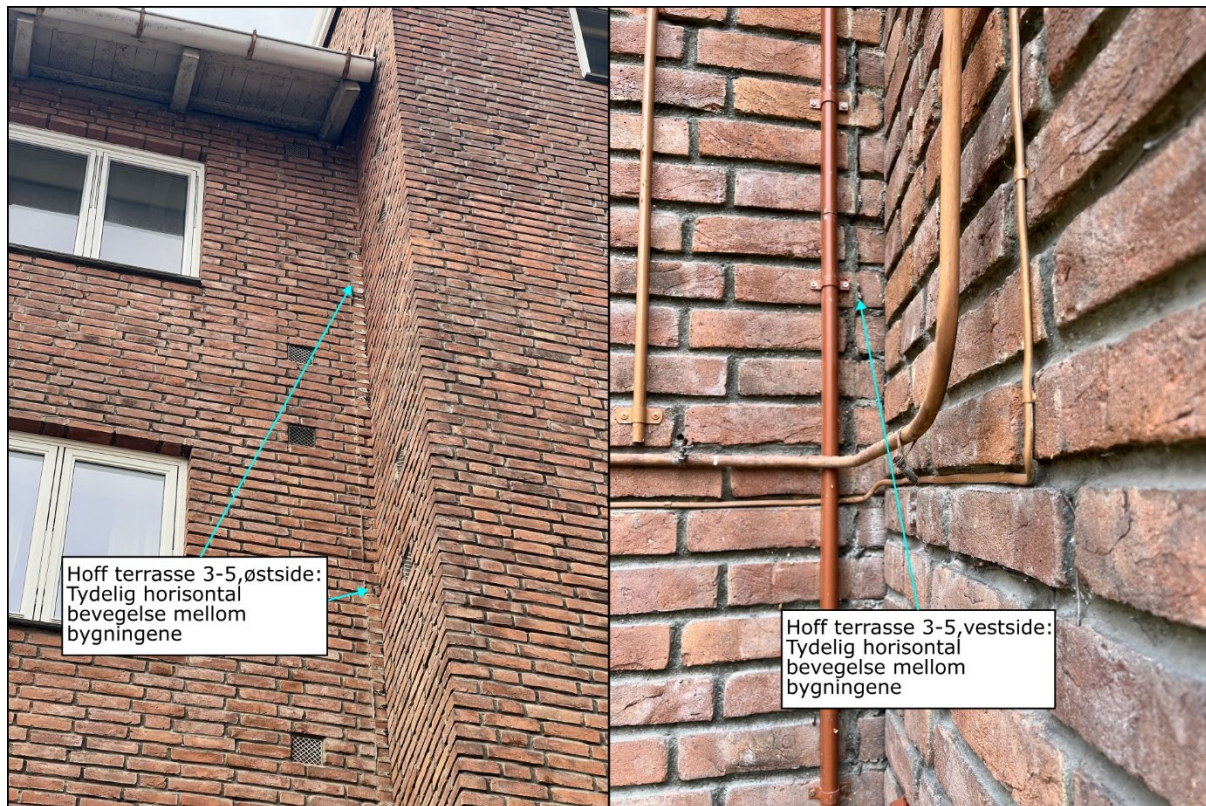
Figur 6-2. Bilder av overgangen mellom Hoff terrasse 3 og 5 fra befaring 11.03.2024
