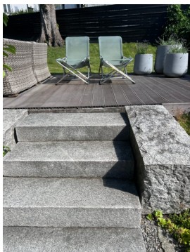
Markterrasse, forstøtningsmur og trapp i terreng.
