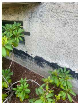
Synlig grunnmur, dels utvendig slemmet over terreng.
