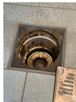
Plastsluk med klemring for membran.
