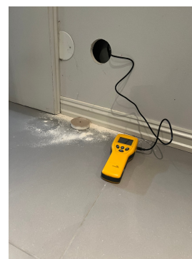
Hullboring og fuktsøk utenfor dusjsone i bad 1 kjeller.
