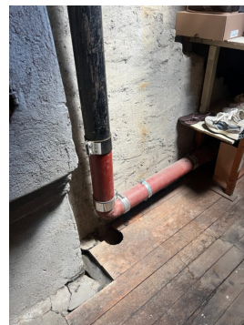
Avløpsrør og lufting over tak på loft.
