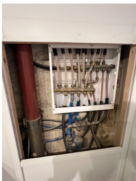
Vann- og avløpsrør under kjøkkenkum.
