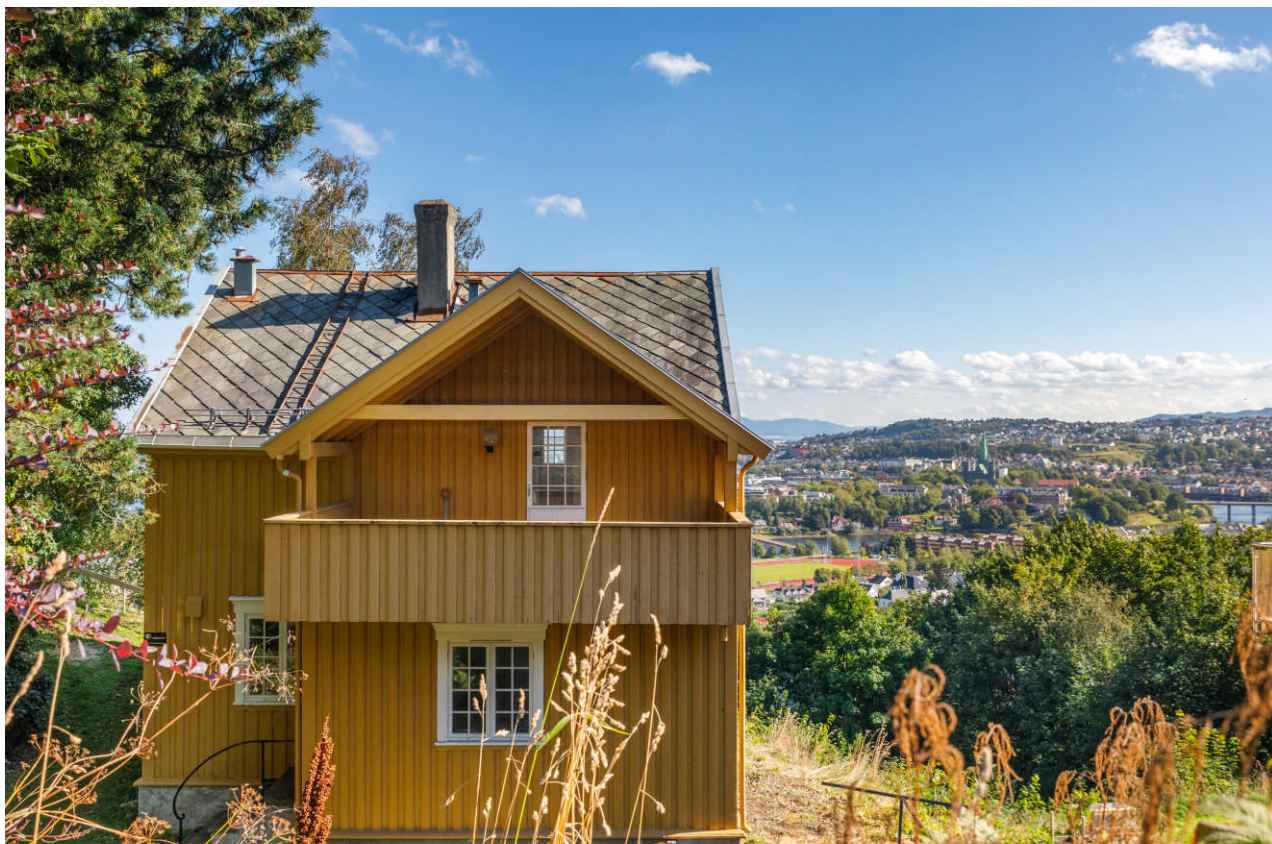
Fasade bakside. Det er veranda i 2.etg.
