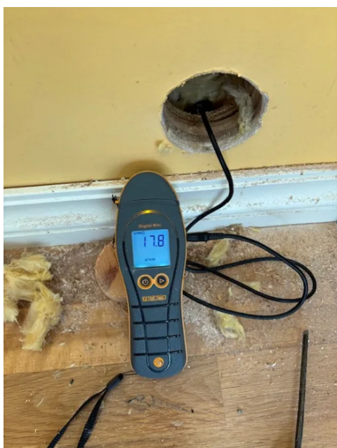
Hulltaking med fuktmåling mot våtsone uten avvik målt fra tilliggende kjøkken.
