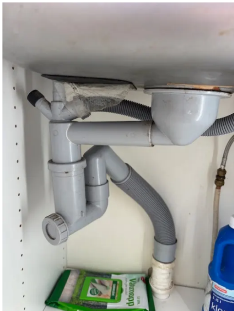
Avløpsrør i underskap vask på kjøkkenet.
