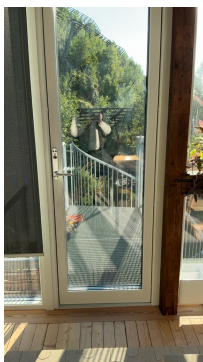
TG 1 Balkonger, terrasser og rom under balkonger
