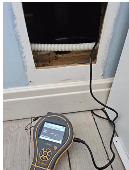
Våtrom - [Fuktmåling bad 2.etg.]
