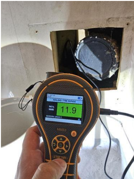
Rom under terreng (kjeller, underetasje, sokkeletasje) - [Fuktmåling utlektet kjellevegg.]
