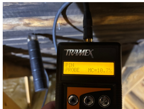
Det ble ikke registrert fukt i undertaket ved befaringstidspunktet.
