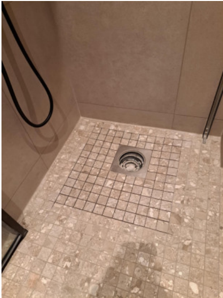
7 (I etage wet room main house 1, 16.03.2025.jpeg)
