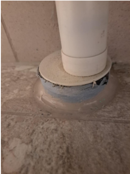
13 (I etage wet room main house 7, 16.03.2025.jpeg)
