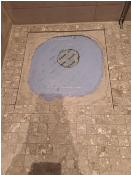
8 (I etage wet room main house 2, 16.03.2025.jpeg)
