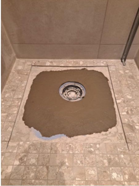
19 (I etage wet room main house 13, 16.03.2025.jpeg)
