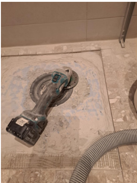
18 (I etage wet room main house 12, 16.03.2025.jpeg)
