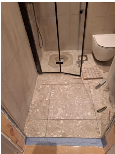
9 (I etage wet room main house 3, 16.03.2025.jpeg)
