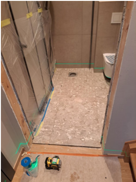
17 (I etage wet room main house 11, 16.03.2025.jpeg)
