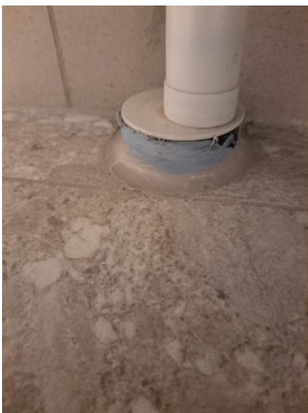
15 (I etage wet room main house 9, 16.03.2025.jpeg)
