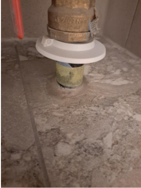
16 (I etage wet room main house 10, 16.03.2025.jpeg)
