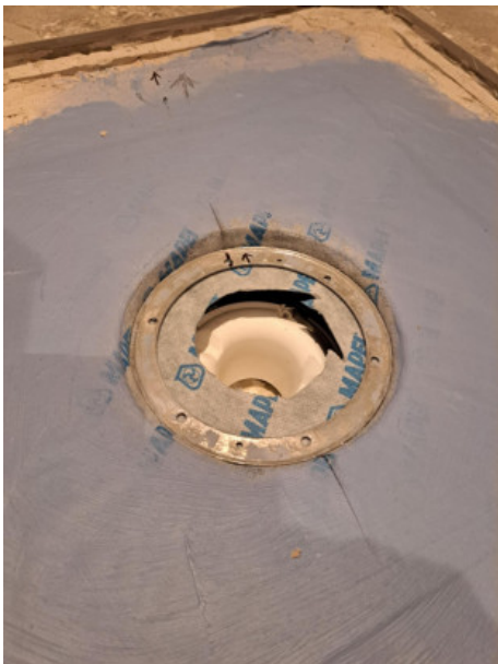
9 (II etage Vaskerom 5,16.03.2025.jpeg)
