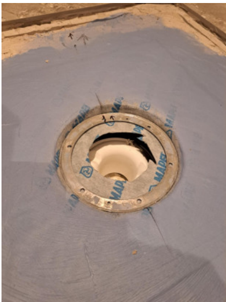
12 (II etage Vaskerom 5,16.03.2025.jpeg)
