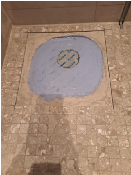
8 (I etage wet room main house 2, 16.03.2025.jpeg)
