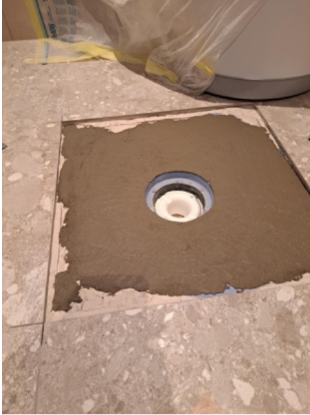
10 (II etage Vaskerom 3,16.03.2025.jpeg)
