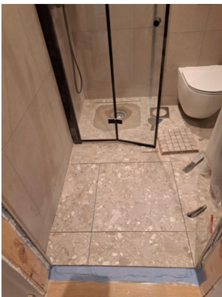
9 (I etage wet room main house 3, 16.03.2025.jpeg)
