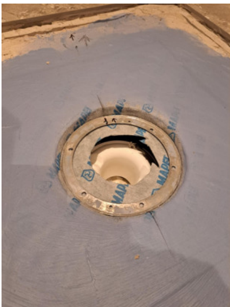
3 (II etage Vaskerom 5,16.03.2025.jpeg)
