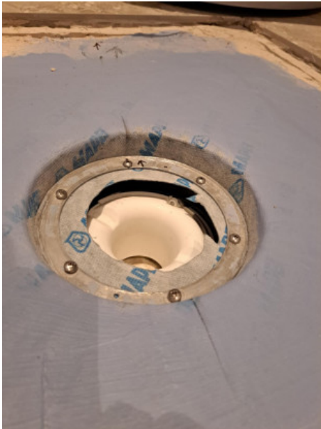
4 (II etage Vaskerom 8,16.03.2025.jpeg)
