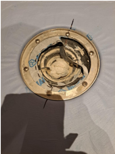
8 (I etage wet room main house 8, 16.03.2025.jpeg)
