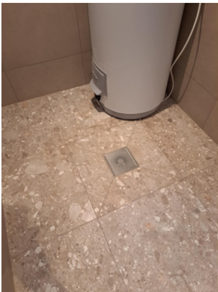
9 (II etage Vaskerom 2,16.03.2025.jpeg)
