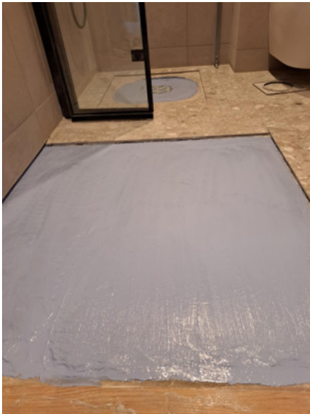
20 (I etage wet room main house 16.03.2025.jpeg)
