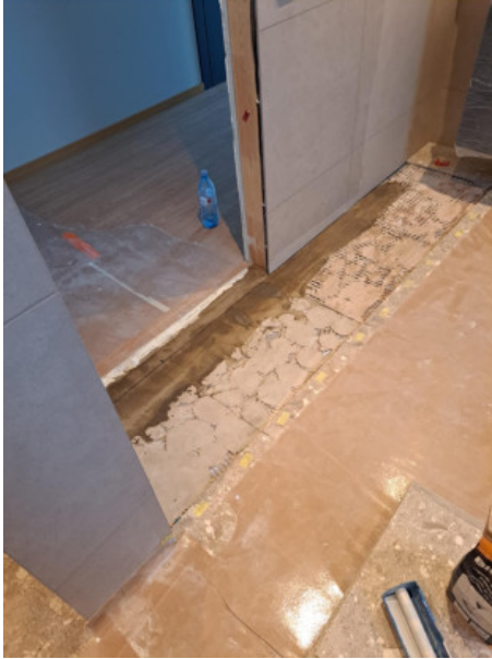
13 (II etage Vaskerom 6,16.03.2025.jpeg)
