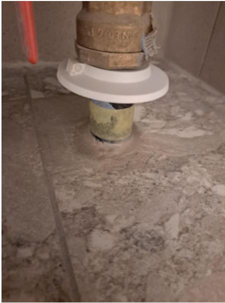
16 (I etage wet room main house 10, 16.03.2025.jpeg)
