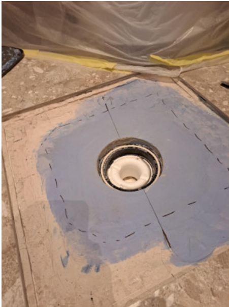
7 (II etage Vaskerom ,16.03.2025.jpeg)
