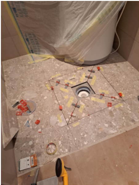
11 (II etage Vaskerom 4,16.03.2025.jpeg)
