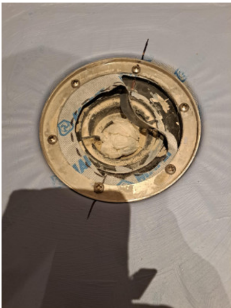
14 (I etage wet room main house 8, 16.03.2025.jpeg)
