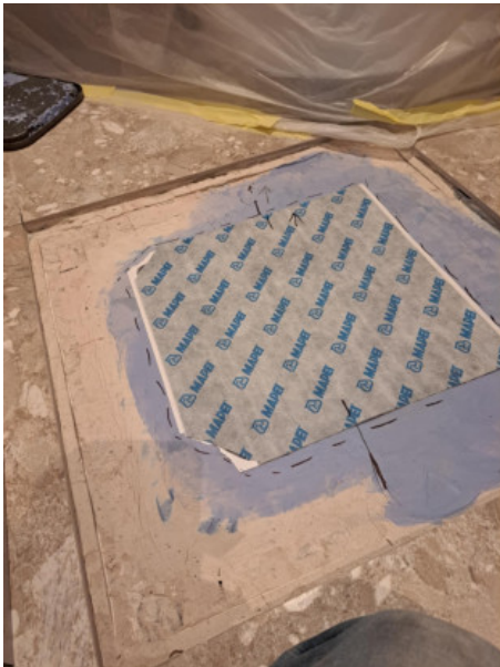
8 (II etage Vaskerom 1,16.03.2025.jpeg)
