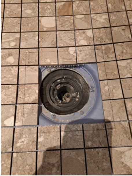
7 (I etage wet room main house 5, 16.03.2025.jpeg)
