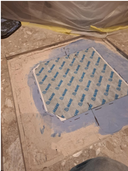
2 (II etage Vaskerom 1,16.03.2025.jpeg)
