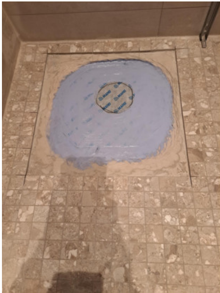
8 (I etage wet room main house 2, 16.03.2025.jpeg)
