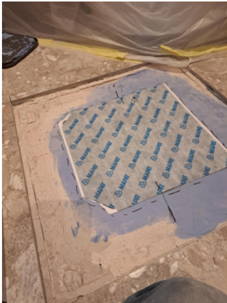
8 (II etage Vaskerom 1,16.03.2025.jpeg)
