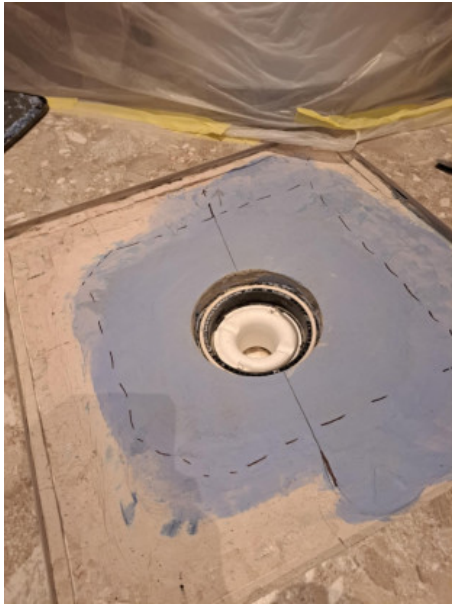
7 (II etage Vaskerom ,16.03.2025.jpeg)
