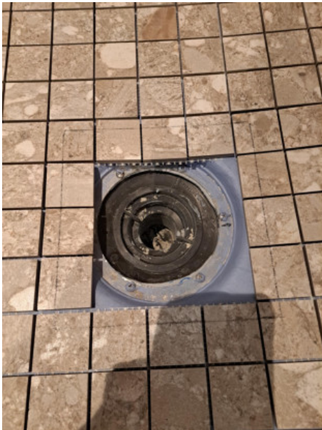
11 (I etage wet room main house 5, 16.03.2025.jpeg)
