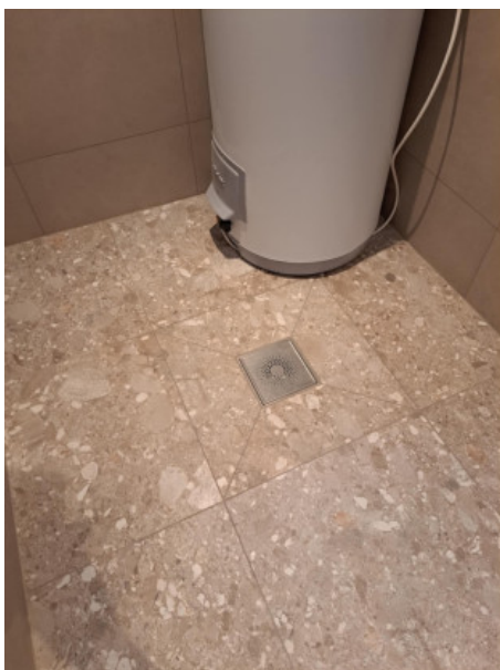
9 (II etage Vaskerom 2,16.03.2025.jpeg)
