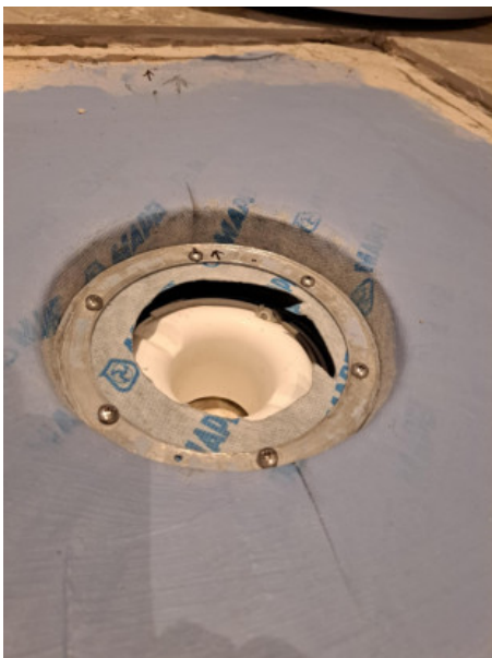
15 (II etage Vaskerom 8,16.03.2025.jpeg)
