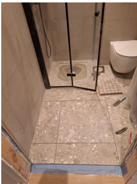
9 (I etage wet room main house 3, 16.03.2025.jpeg)
