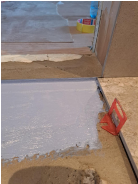
14 (II etage Vaskerom 7,16.03.2025.jpeg)
