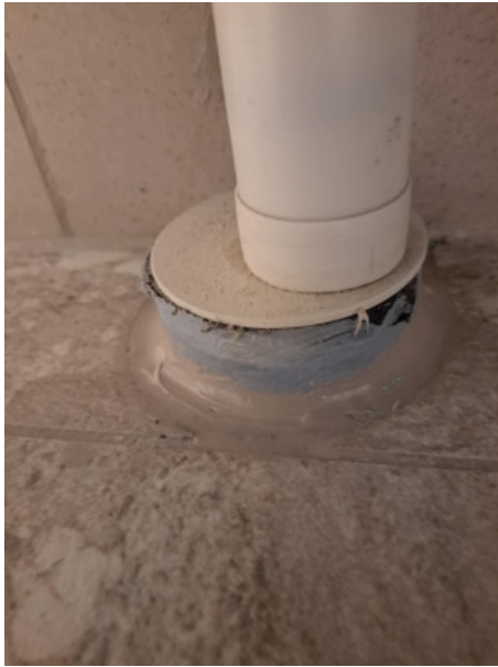
13 (I etage wet room main house 7, 16.03.2025.jpeg)
