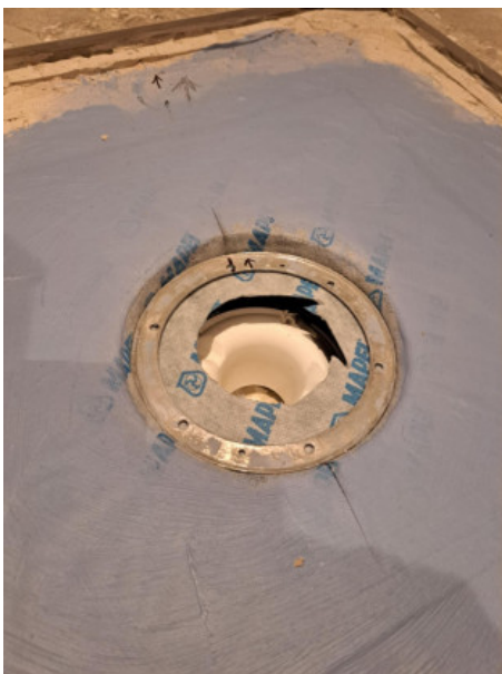
3 (II etage Vaskerom 5,16.03.2025.jpeg)
