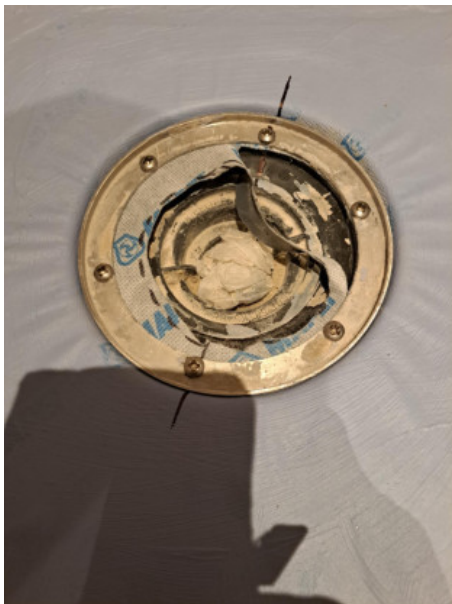
14 (I etage wet room main house 8, 16.03.2025.jpeg)
