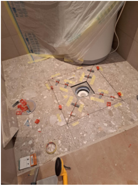
11 (II etage Vaskerom 4,16.03.2025.jpeg)
