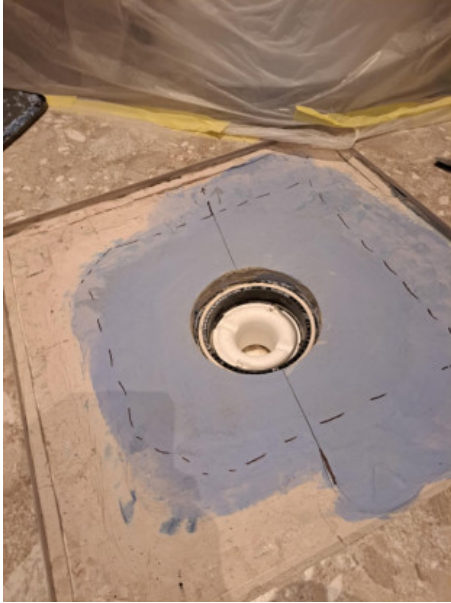
1 (II etage Vaskerom ,16.03.2025.jpeg)
