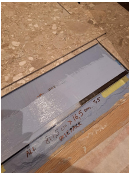
12 (I etage wet room main house 6, doorback 16.03.2025.jpeg)
