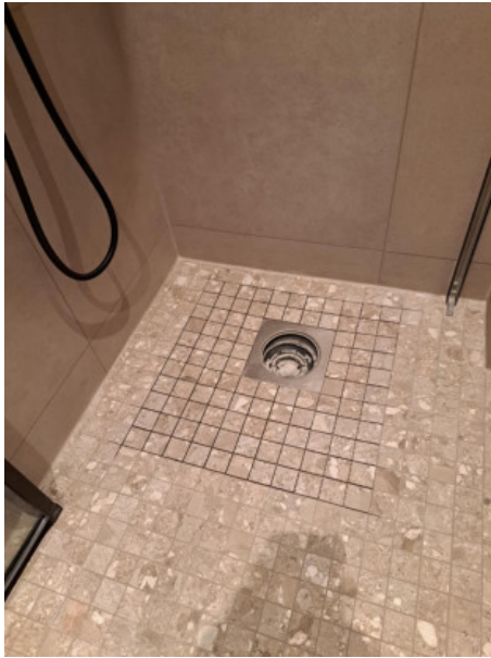
7 (I etage wet room main house 1, 16.03.2025.jpeg)
