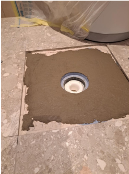
10 (II etage Vaskerom 3,16.03.2025.jpeg)
