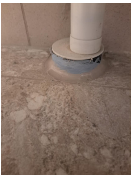
15 (I etage wet room main house 9, 16.03.2025.jpeg)
