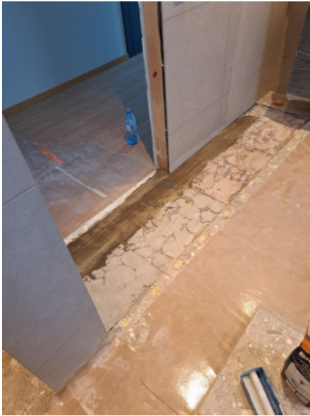
13 (II etage Vaskerom 6,16.03.2025.jpeg)
