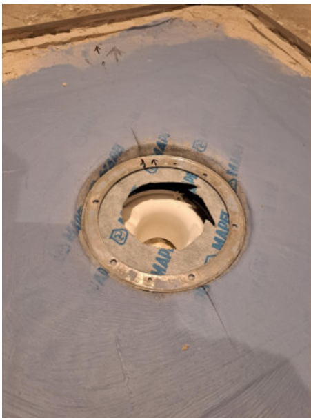
12 (II etage Vaskerom 5,16.03.2025.jpeg)
