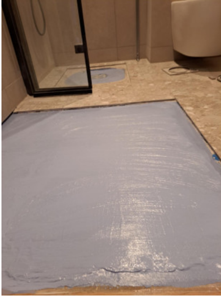
10 (I etage wet room main house 4, 16.03.2025.jpeg)
