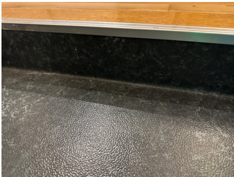
Overgang mot dørterskel.
