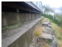
Støpt nye fundamenter og forsterket.
