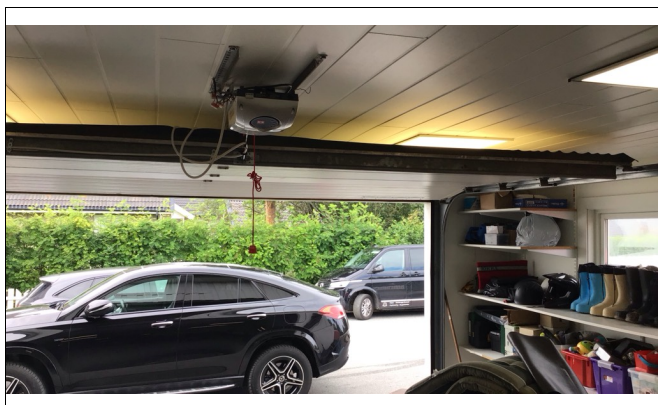
Elektrisk port i garasje
